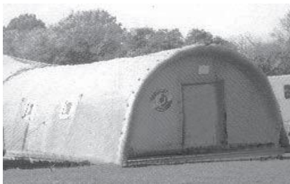
Рис. 6.1.5. Підрозділ госпітала, який розгорнуто у пневматичних модулях: а) вид зовні; б) вид усередині.
