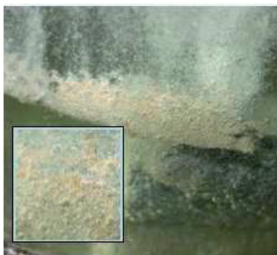
Рис. 20. Образование гидроксида (оксида) железа при растворении железной оболочки
