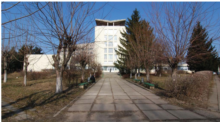
Інститут загальної та невідкладної хірургії, збудований 1975 р.
