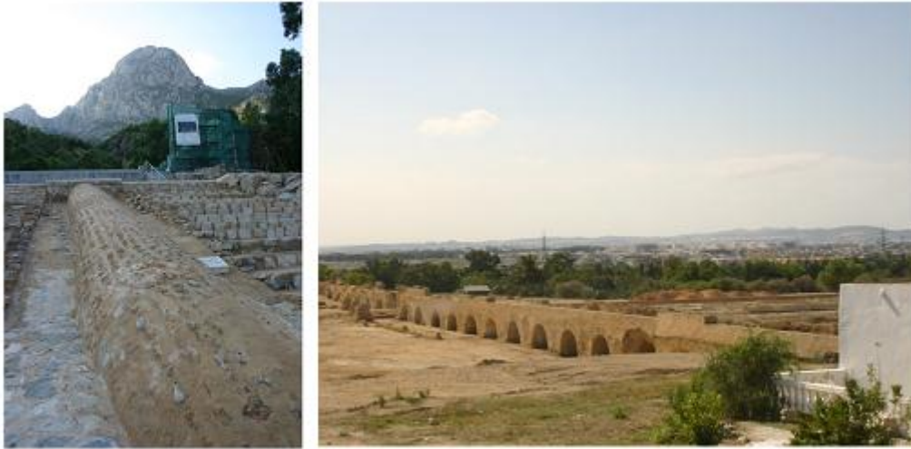
Рисунок 26. Керамический трубопровод сбора воды в Атласских горах и фрагменты Карфагенского акведука.
